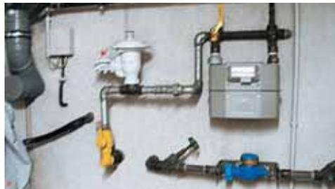
Beispiel 3: Anschlüsse (Strom, Gas, Wasser und Telekom) für nicht unterkellerte Gebäude unter Verwendung einer Mehrspartenhaueinführung (MSHE)
