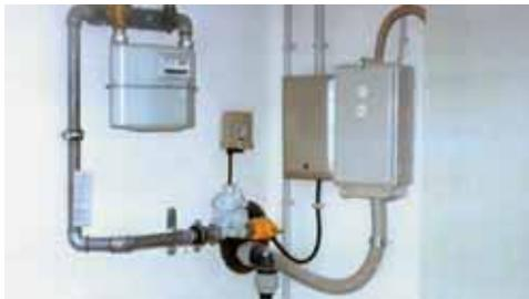
Beispiel 2: Anschlüsse (Strom, Gas, Wasser und Telekom) für Gebäude mit Keller in konventioneller Ausführung (bei größeren Nennweiten)
