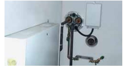
Beispiel 4: Anschlüsse (Fernwärme, Strom, Wasser, Telekom) unter Verwendung einer Mehrspartenhauseinführung während der Bauphase
